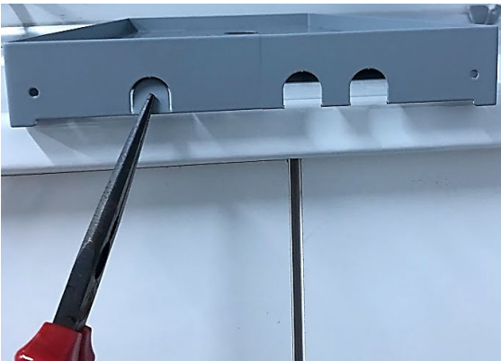
Sıva üstü montaj setinin kanallarının çıkarılması (Bu kanallar alt kısımda kalacaktır).
