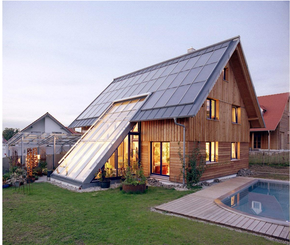
Foto: Bausparkasse Schwäbisch Hall / Lorenz-Behälterbau
