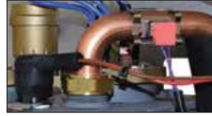
NTC sensör ve STB (limit termostat)
